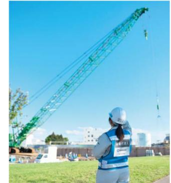
▲山口さんが担当するのが、岩見沢市の大和跨線橋撤去工事。廃路線に残った橋を撤去するもので、この現場代理人を務めます。工事には、200トンのクローラークレーンが使われて大迫力!
