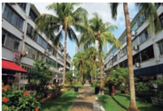
写真4 住棟間の緑道
