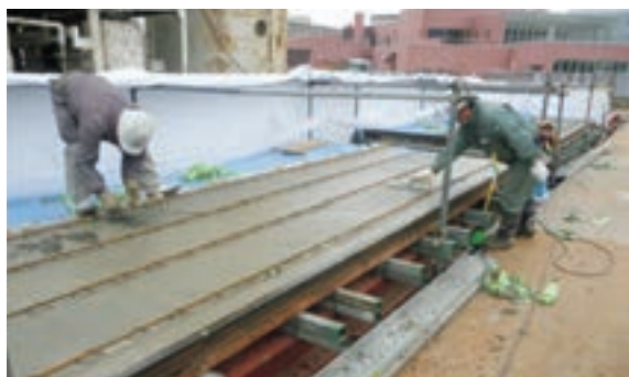
サイト PCa の床板の製作状況
