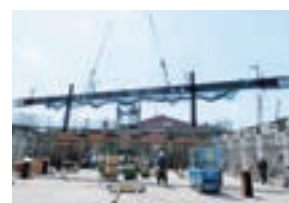
25m 梁の施工状況
