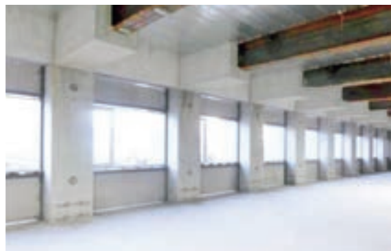
PCa 柱と CS ビームの繰り返しによる大空間架構
