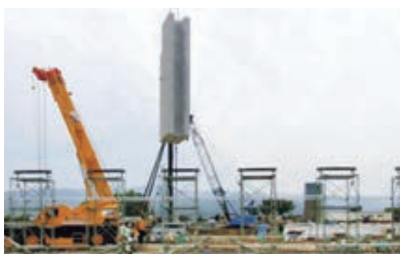
PCa 柱の組み立て状況
