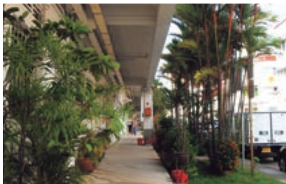
写真3 戦前住棟の連続歩廊
