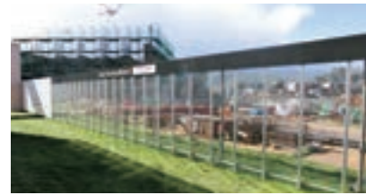
1階部分の展望を確保するためにクリアパネル仮囲い
